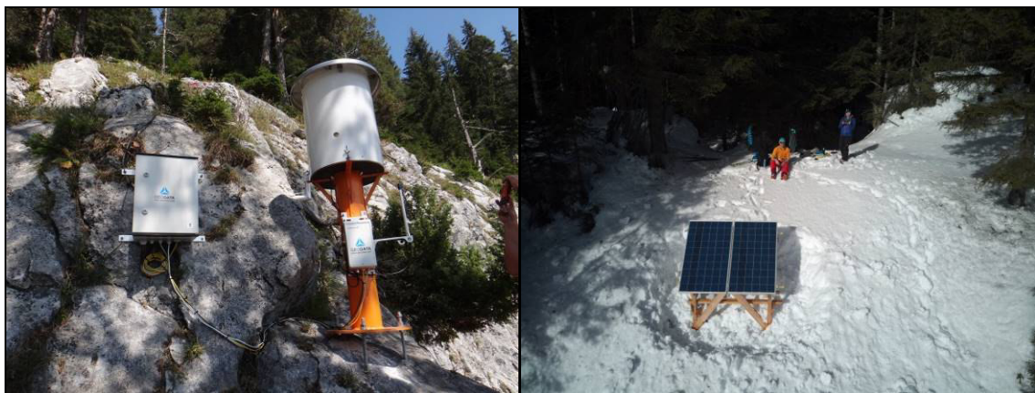
Abb. 7: Totalstation (links) und Solaranlage unterhalb der Pürggerwand.
