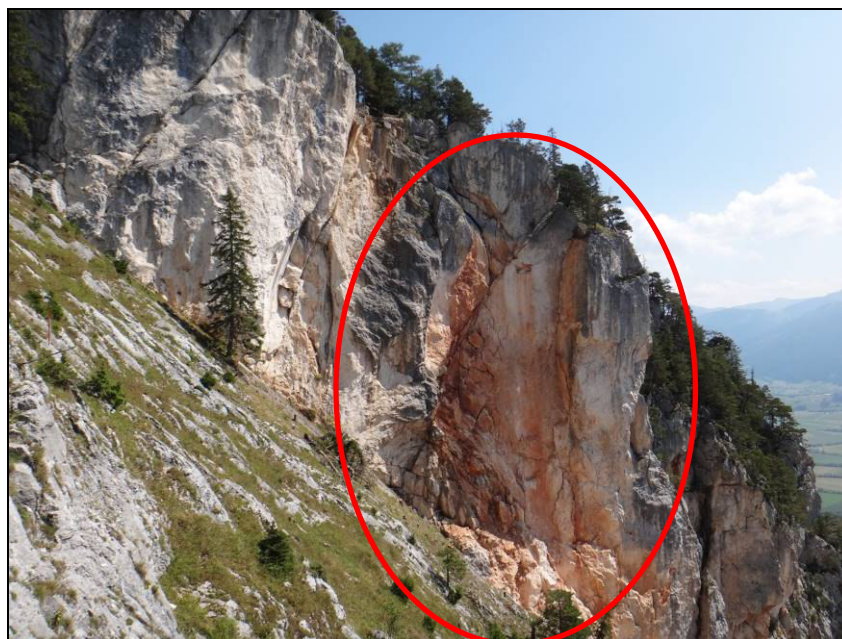
Abb. 3: Pürggerwand, Aufnahme vom 22.08.2018, (Ausbruch rot markiert).
