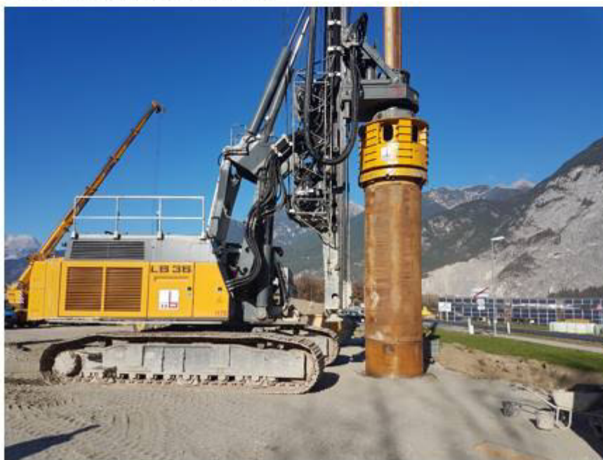
Kellybohranlage (bis 49 m uGOK)
