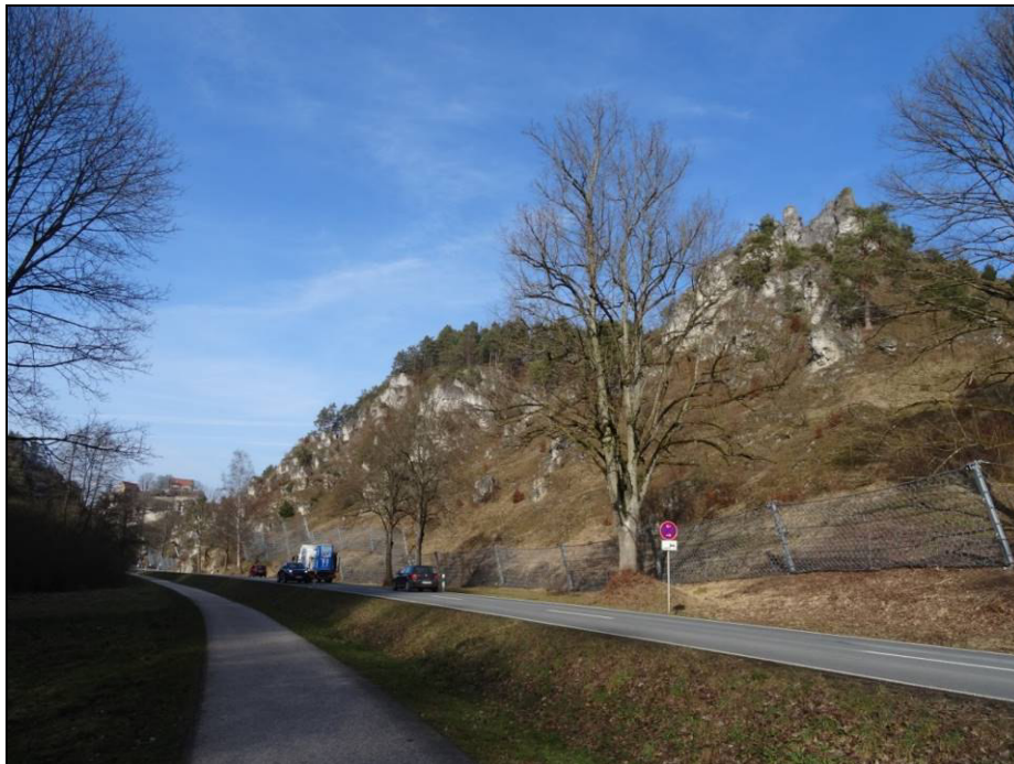
Abb. 8: Südliche Ortszufahrt von Pottenstein mit Steinschlagschutzzäunen
