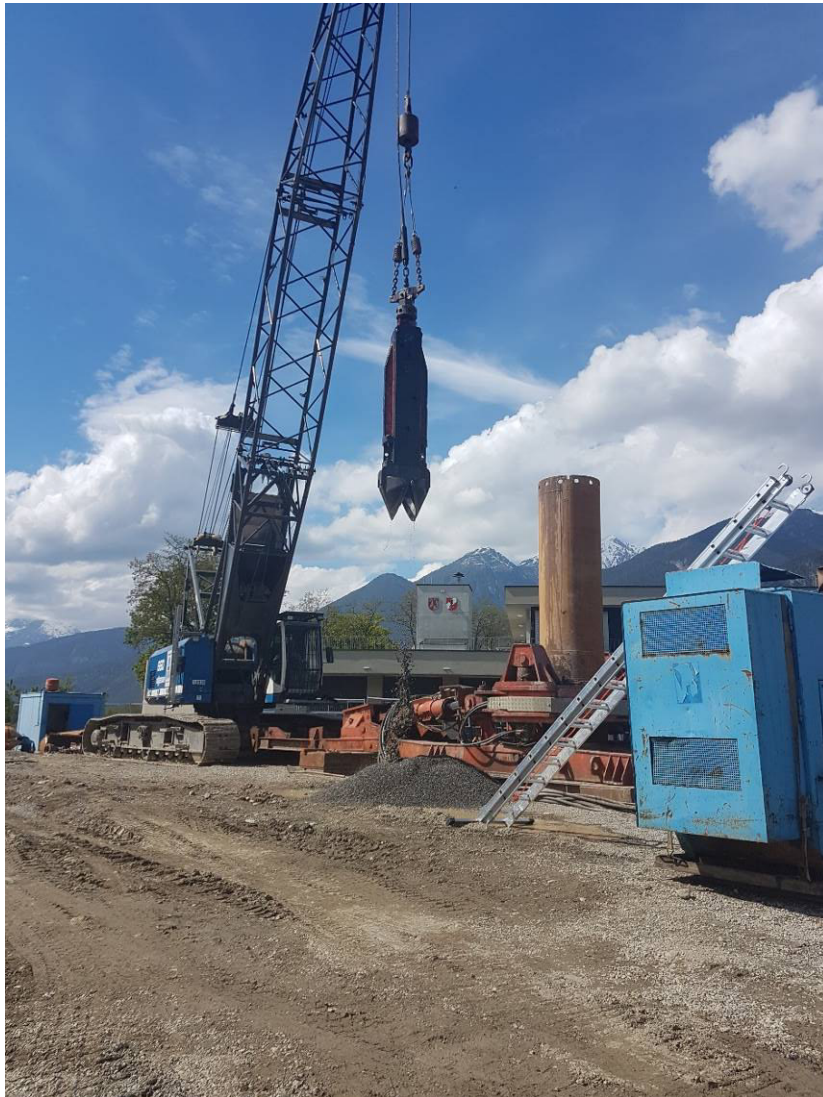
Greiferbohranlage (von 49 bis 112 m uGOK)
