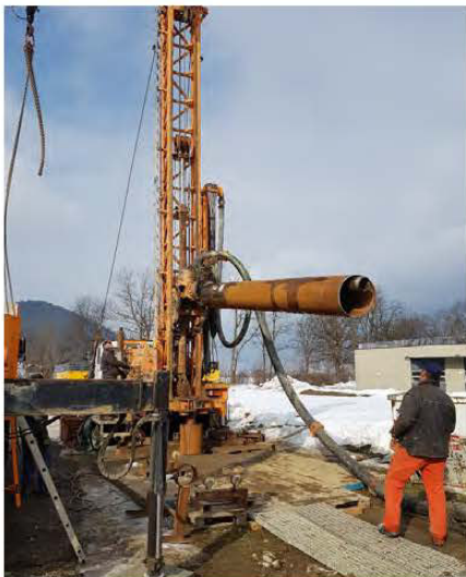
Stahlrohr DN 500, Doppelwandgestänge für Imlochhammer
