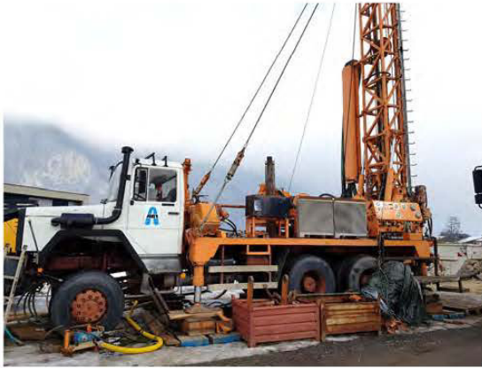
RB50-Bohrgerät, Gerät 7502, LKW 6414, Bauweise Nr. 9506, 5267
