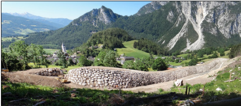
Abb. 9: Fertiggestellter Steinschlagschutzdamm Pürgg.
